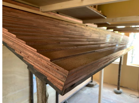
写真7 ミダスメタルを用いたこけら葺風瓦
