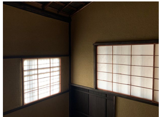
写真3 巧妙に配置された下地窓と連子窓を再現
