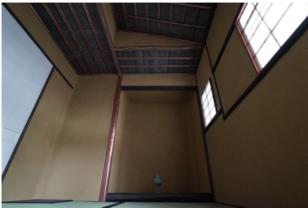
写真2 天井まで塗り回した室床を再現
