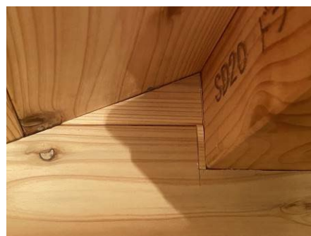
写真3 母屋と内壁・天井の納まり：端材で隙間を充填
