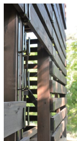
写真13 外壁雪囲い ルーバー・十手金物
