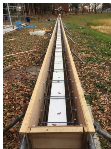
写真5 腰壁型枠組立
