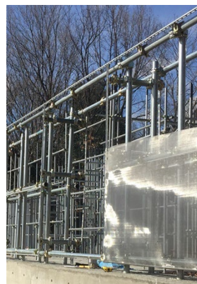
写真8 ステンレス金網装着
