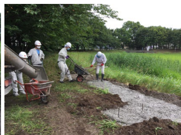
写真4 レベルコン打設
