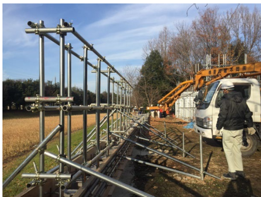
写真6 ピクチャ・ウィンドウの仮設単管組立
