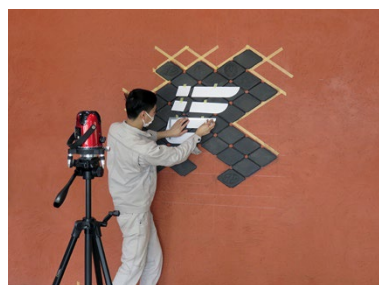
図 16 銅板設置のための罫書き作業
