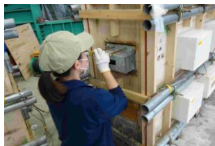
(i)ボルト差込み
