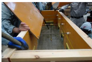
(a)コンクリート打込み
