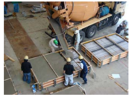
図5 浮体コンクリートの打設
