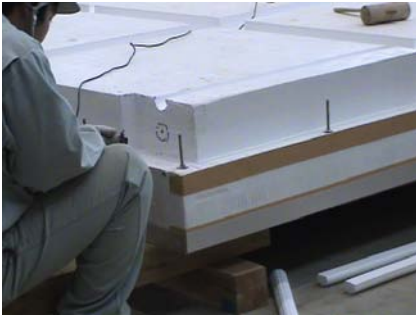
図3 建設用スチールの加工
