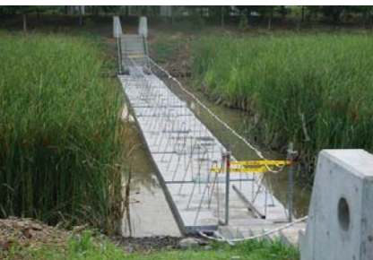
図13 浮体橋の完成
