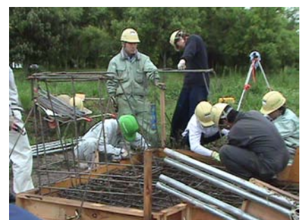
図8 アバットの鉄筋組立
