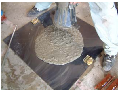
図6 高強度コンクリートの使用
