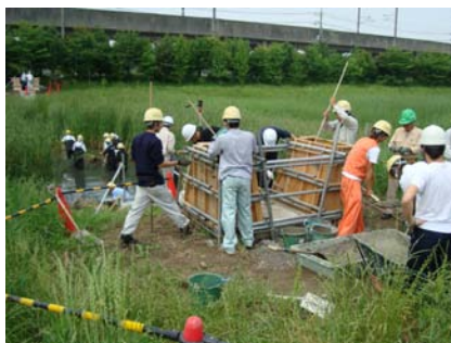
図9 アバットのコンクリート打設
