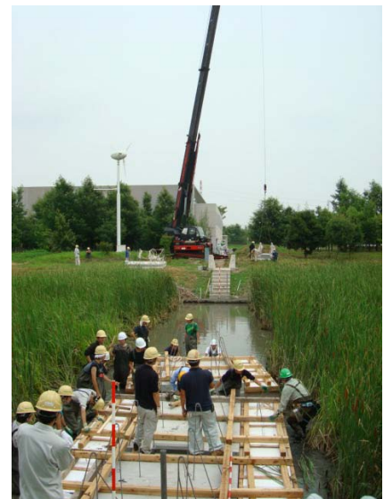
図11 浮体の設置状況
