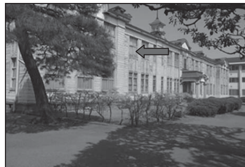
2) 修理前現状窓は上階が引違窓
