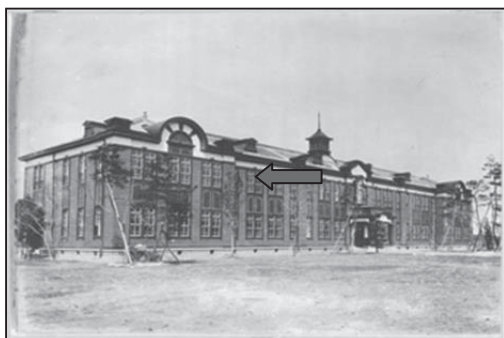
1) 創建当初の窓は全て上下窓
