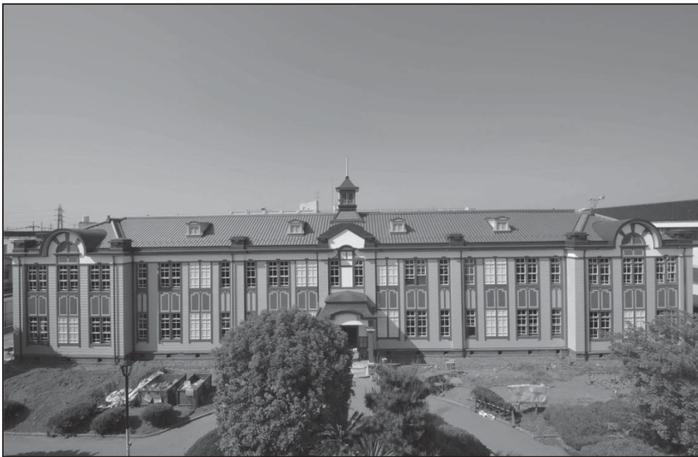
図5 竣工（復原工事完了）記念館正面写真（平成25年5月18日撮影）
